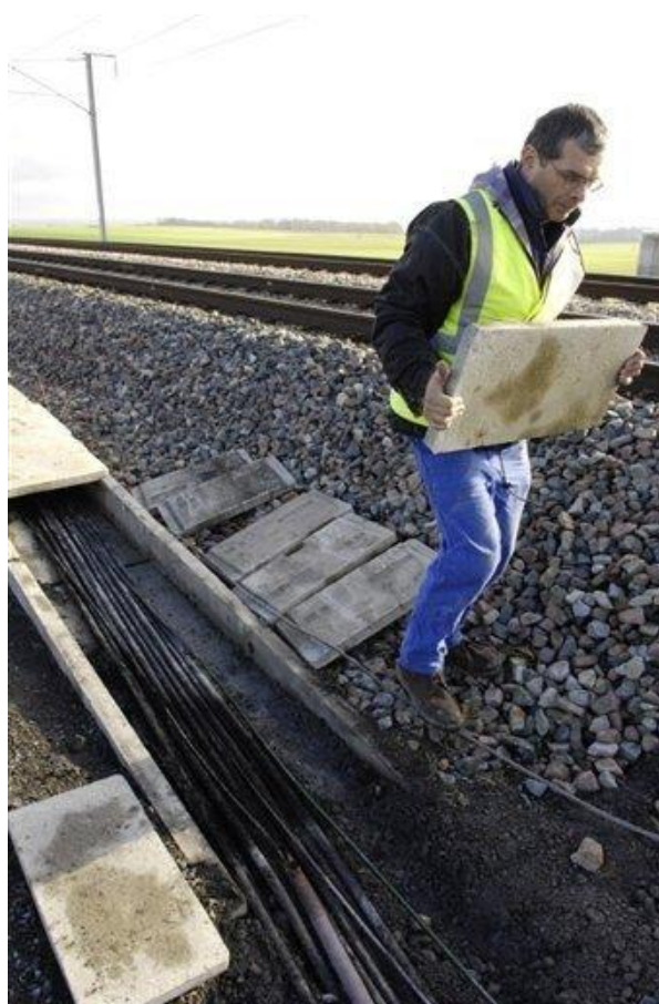
Câbles de la SNCF sabotés à Varrèdes (est de Paris).
